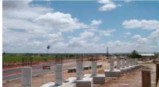
Execução do viaduto sobre linha férrea I
